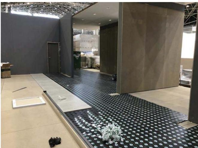
Tiene una mayor rapidez de instalación, ya que se puede realizar la instalación de la MANTA FLEX UF Decor sobre toda la superficie y seguidamente iniciar la colocación de las piezas que utilizaremos como pavimento.
