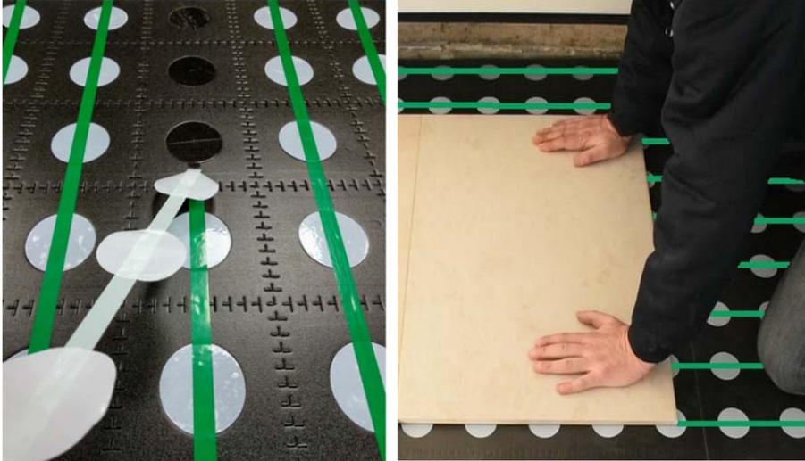
En la otra cara encontraremos una serie de discos troquelados en continuo que son los que se fijaran a la nueva pieza del suelo a colocar retirando nuevamente el film desechable.
